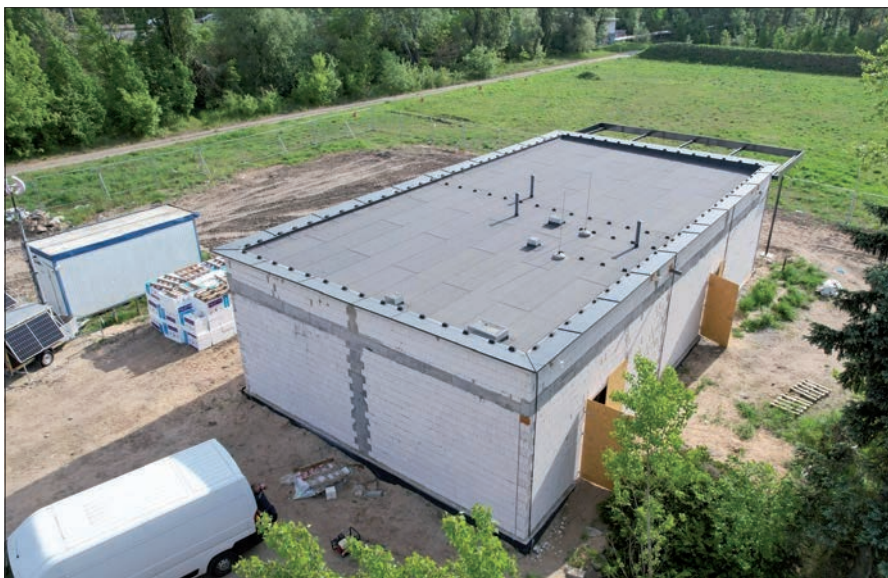
Centrum Sportu Łuczniczego w budowie
